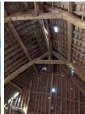
Émondage et construction traditionnelle.
