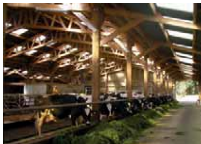
Poteaux à Kermeur ( chêne local )
