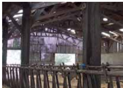
Bardage à St-Onen-la-Chapelle ( pin de l'exploitation )
