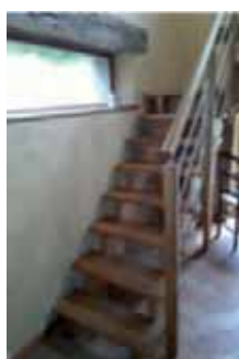
Escalier à St-Thurial ( châtaignier de la ferme )
